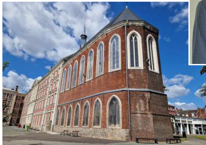
▲ L'extérieur de la chapelle Saint-Edmund est visible depuis la cour du lycée Corot.
